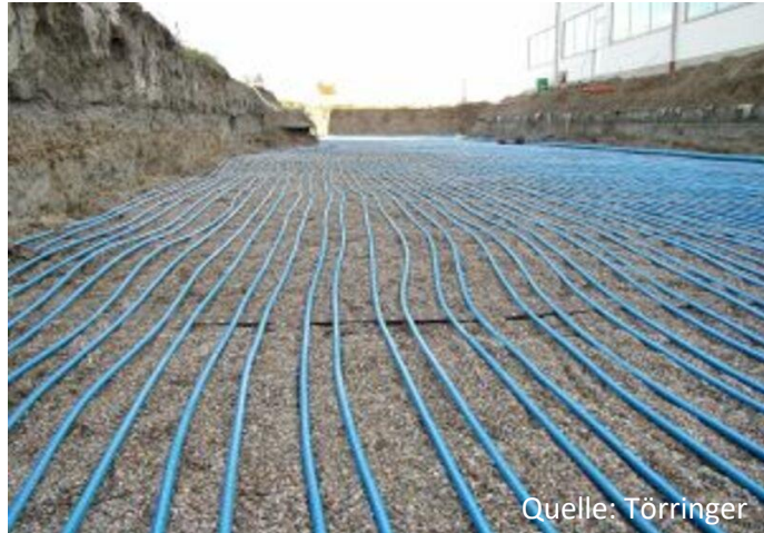
Abbildung 26: Erdwärmekollektor (Bild: (Bundesverband Geothermie e.V., 2023))
